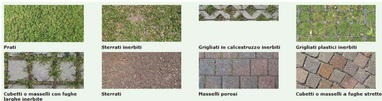
Esempi di pavimentazioni permeabili
