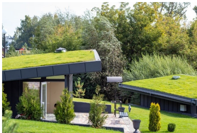
Esempio di tetto verde
